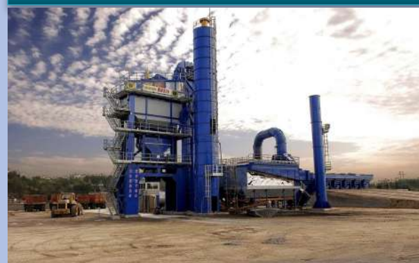
Строительство асфальтного завода
