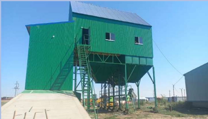
Строительство мехтока, ИП Глава КФХ Григорьев И.С.
